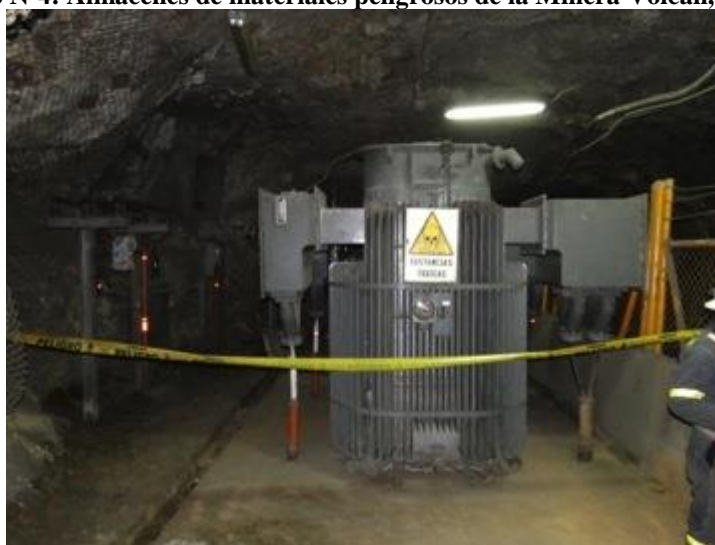
Foto N° 5: Transformador con presencia de PCB almacenado temporalmente.
