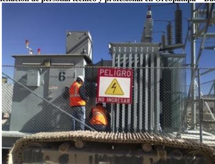
Foto N° 16: Extracción de muestras de aceite en Southern Cooper – Perú.
